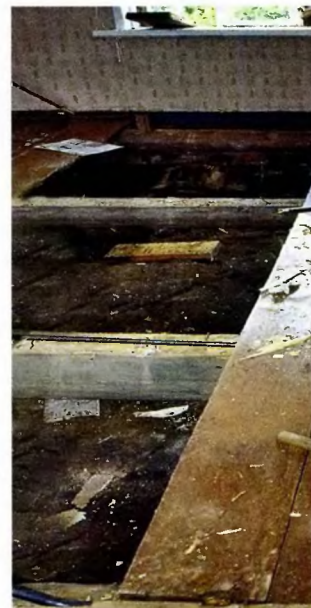
Чтобы работать было удобно бревно пришлось демонтировать перегородки в доме и снять полы.
