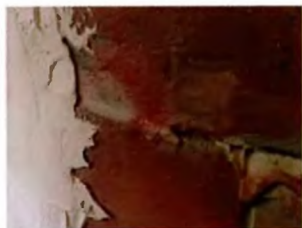
Нанесение слоя штукатурки на грунтovку произошло небольшим слоем.
