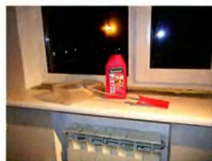
Начинаем работу: грунтуем поверхность старого подоконника.
