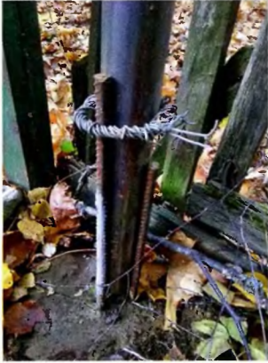
Труба вставлена между арматуринами и связана проволокой.
