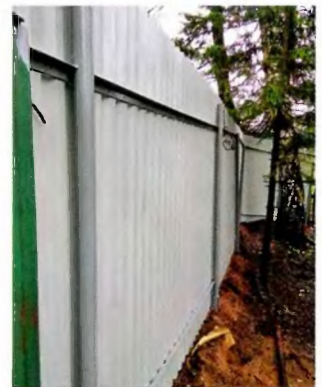
Новый забор установлен. Подзаборная щель засыпана грунтом.
