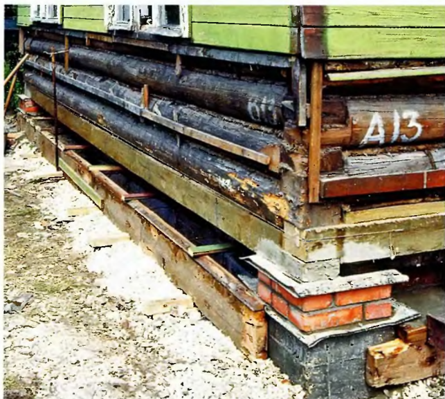
Дом поставлен на прочную опору (бетонный столбик с кладкой в два кирпича) теперь можно приступать к изготовлению ленты фундамента.
