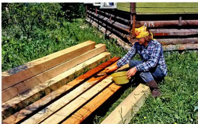
Для замены нижнего венца использовали стандартный брус сечением 150 × 150 мм. Перед установкой брусьев их обрабатывали антисептиком.
