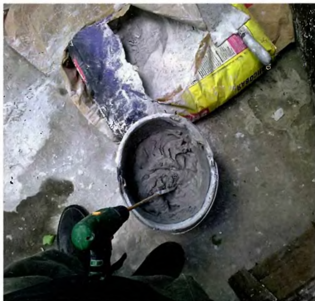
Размешивание штукатурной смеси шуруповёртом.
