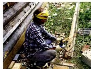
Арматуру нарезали болгаркой.
