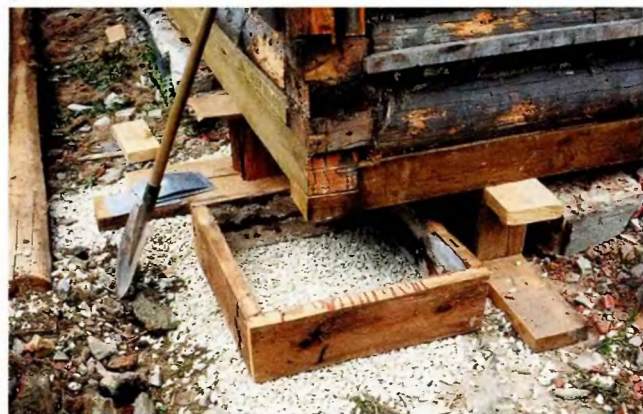
Бетонную плиту под угол дома отливали на гравийной подушке толщиной 10–15 см.
