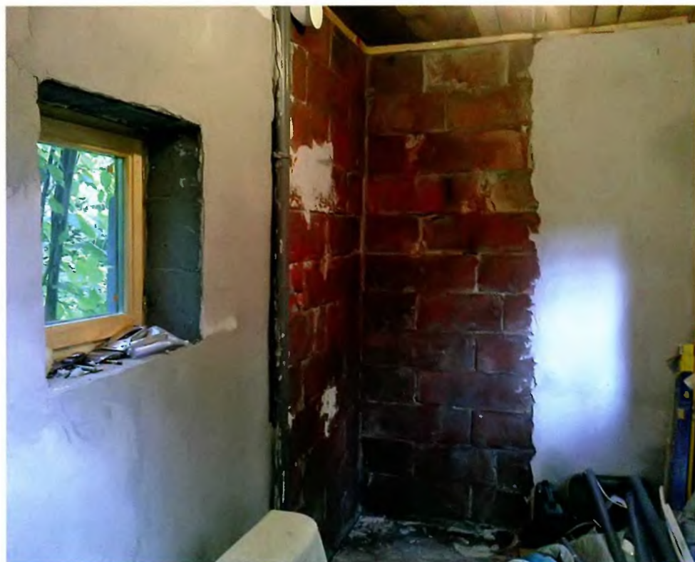
Неоштукатуренный угол. Стены в углу покрыты грунтovкой поверх пенобетона, справа виден оштукатуренный участок.
