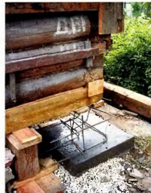
Следующий шаг — монтаж арматуры.
