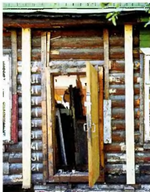
Чтобы венцы не разошлись во время подъема сруба их скрепили досками с обеих сторон.
