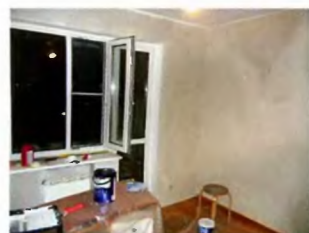
Мы заменили старое окно и начали косметический ремонт в комнате.
