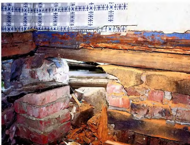
Для установки домкрата необходимо сделать ниши, разобрав часть старого фундамента.
